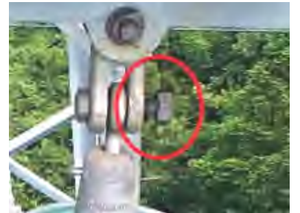
500KV XXX线N25左相金具螺栓螺帽松动及开口销缺失
