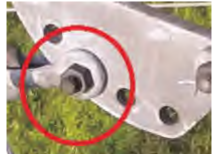
220KV XXX线N120左相小号侧金具开口销缺失
