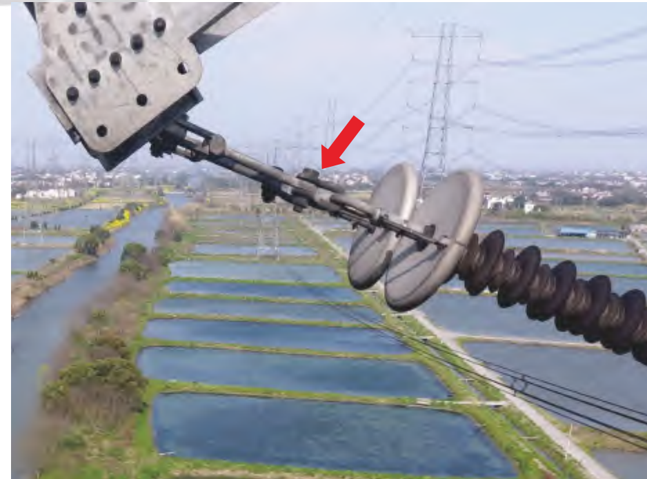
800KV直流 XXX线3487#杆塔_极横担绝缘子挂点销钉缺失
